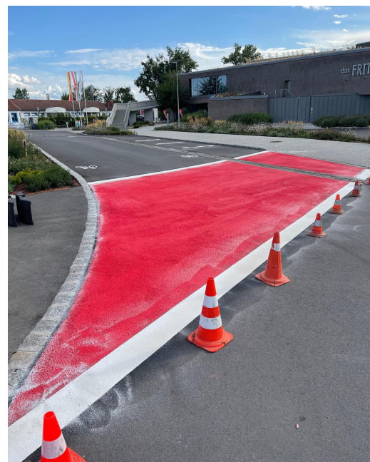
Markierung eines Übergangs mit Plasti Route Rollplast
